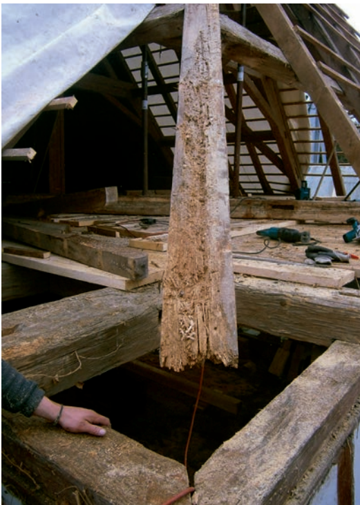
Der mächtige Dachstuhl mit seinem Hängewerk während und nach der Instandsetzung 2014. Diese Art der Dachkonstruktion ist charakteristisch für Keltergebäude, die für den Kelterbaum hohe und stützenfreie Räume benötigten.
