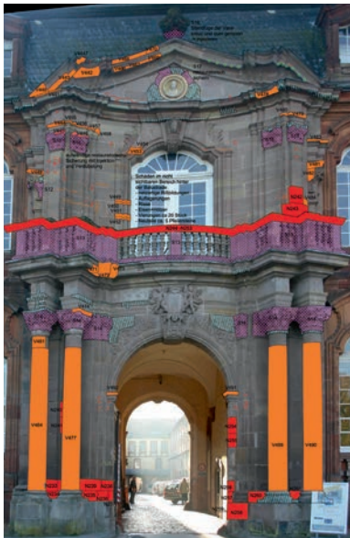
Schadenskartierung des Mittelrisalits Die orange gefärbten Säulen, aus einem Stück gefertigt, sollten möglichst erhalten werden.
